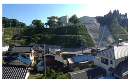
急傾斜地崩壊危険箇所
