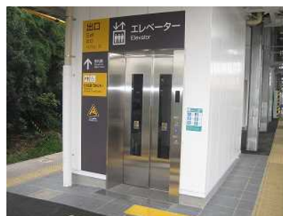
鉄道駅エレベーター
