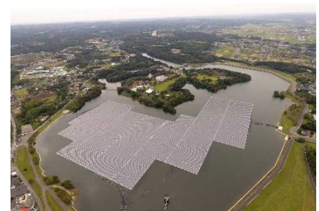
山倉ダムの水上に設置された 千葉・山倉水上メガソーラー発電所
