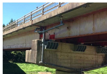
橋梁の耐震補強（取香大橋）
