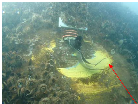
接地線の切断※（上端部）
