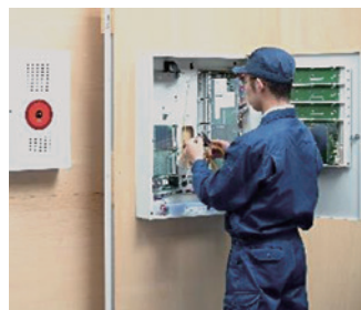
▲ 自動火災報知設備工事の実習
