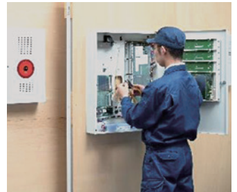
▲ 自動火災報知設備工事の実習
