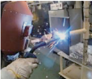
▲ 半自動アーク溶接技能実習
