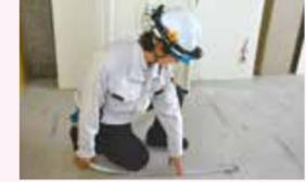
工事に必要な基準線を床などに描く墨出し作業
