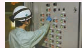
汚泥脱水機の月例点検
