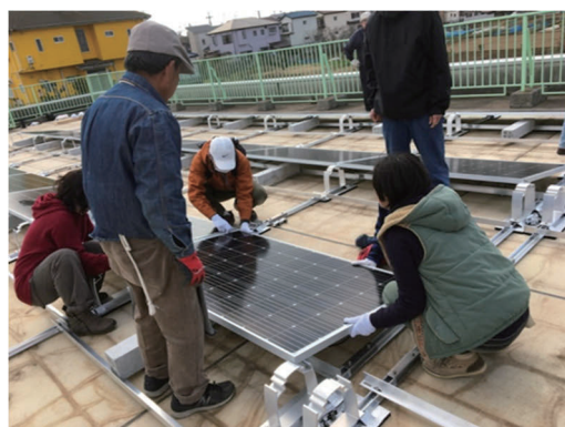
写真-参 10-3 太陽光発電設備の設置
