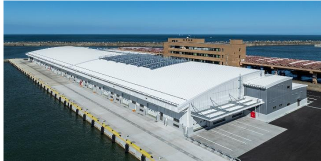
銚子漁港第3卸売市場荷さばき施設
