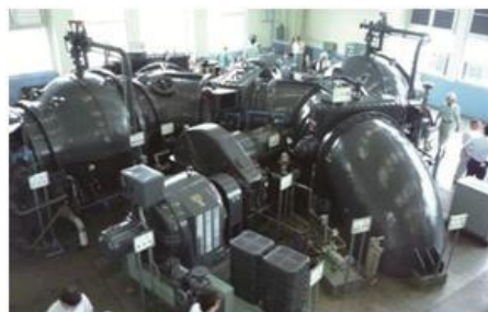
排水ポンプの改修
