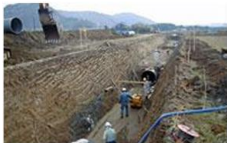
用水路の整備
