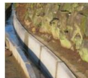
水路の更新 (資源向上支払・長寿命化)
