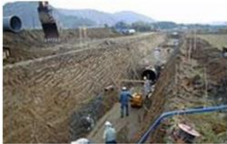
用水路の整備
