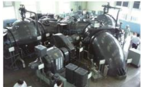
排水ポンプの改修
