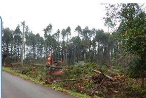
被害森林の伐採作業
