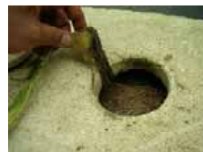
写真3(右) 根の腐敗状況
