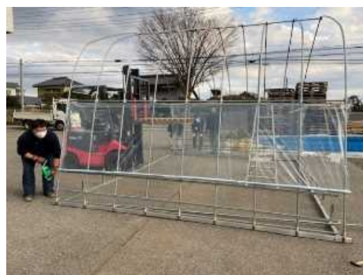
ハウス側窓の開閉部材を取り付けて動作確認をしました
