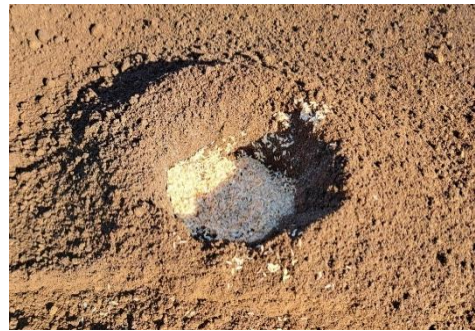
縦穴暗渠の施工状況
