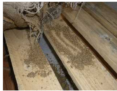
根の周りの乾燥した土の様子
