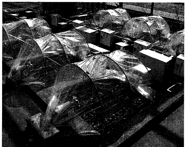
第5-7図 トンネル被覆の状況
