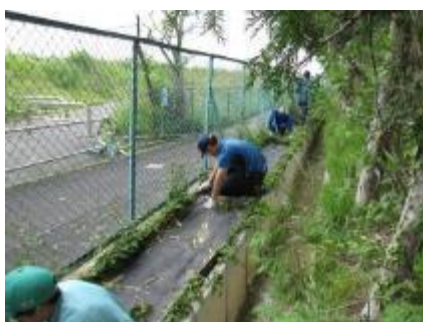
フェンス際の除草
