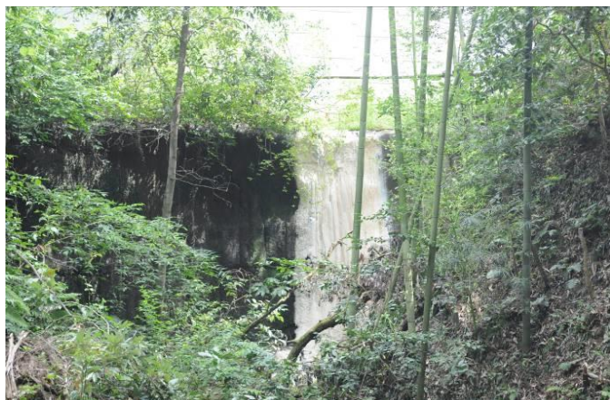
写真 3 コンクリート擁壁から流れる水と沈殿物
