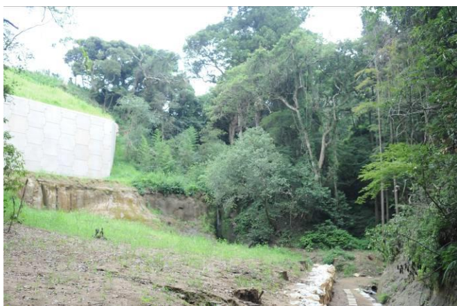
写真 1 補修された崩壊斜面
