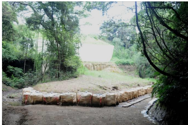
写真 2 参道沿いの土のう
