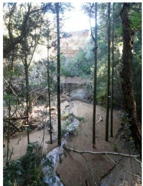
崩壊後の状況（H23.11.21）
