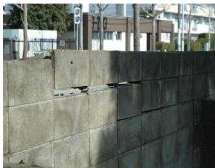
〈崩れそうなブロック塀〉
