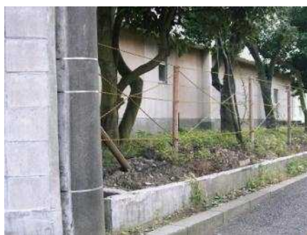
〈取り外されたブロック塀〉
