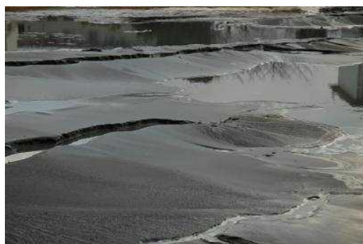
〈液状化に伴う亀裂と噴砂〉
