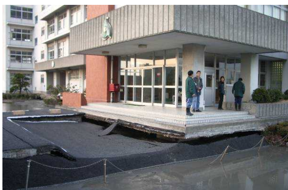
県立浦安南高校の液状化の様子① (玄関前)
