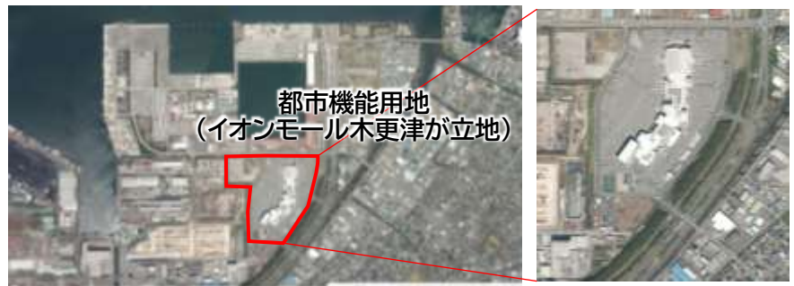
出典:GEOSPACEより作成 図 港湾区域内における商業施設
