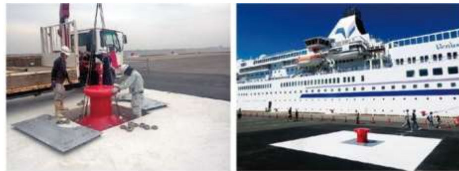
出典:クルーズ船接岸へ向け係船柱改良・新設((一社)日本埋立浚渫協会) 写真 係船直柱を据え付ける様子 写真 試験入港したばしふいっくびいなす
