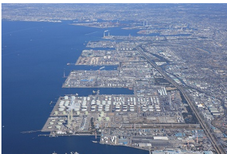
図 2-5-13 千葉港に立地するコンビナート
