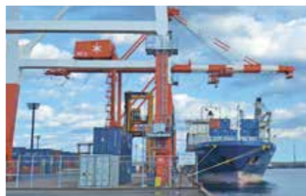
ガントリークレーン Gantry Crane
