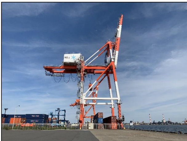
写真：ガントリークレーン1号機
