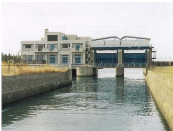
水門・排水機場 [千葉港海岸 (検見川地区)]
