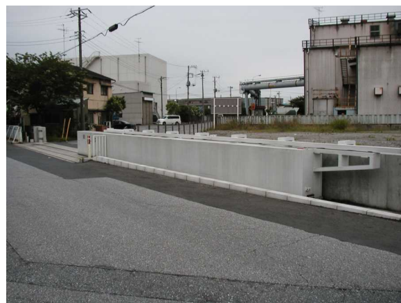
陸閘 [千葉港海岸 (寒川地区)]
