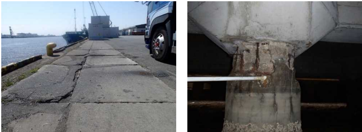
図 2-5-11 港湾施設の老朽化の状況
