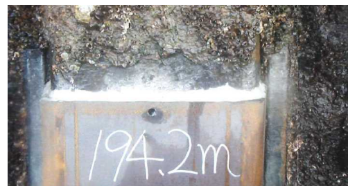
鋼矢板（当て板補修）
