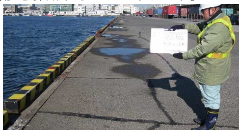
エプロン（ひび割れ・沈下）
