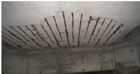
栈橋上部が剥落
