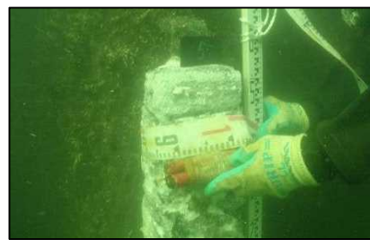
鋼矢板（電気防食）
