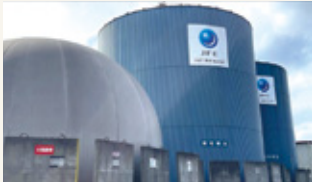
ガスホルダー(左)と消化槽(右)
