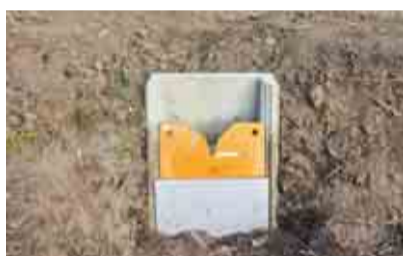
大雨の際に田んぼに水をとどめ、ゆっくり排水するための水位調整板
