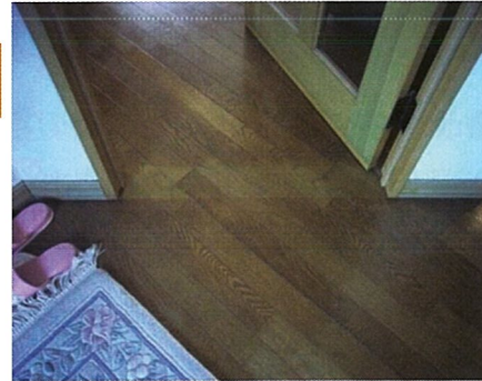
●改善後：下枠の撤去
