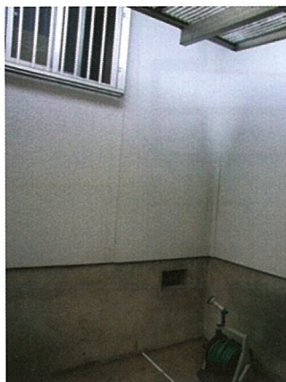
●改善前：車庫部の外壁
