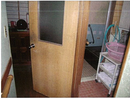
●改善前：洗面所入口
