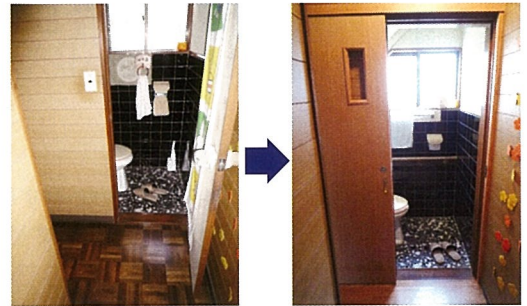
◆ トイレドアの改修事例 開き戸を引き戸に変更
