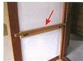
居間の手すり
