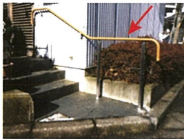
段差にあわせて連続して設置した手すり
