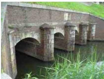
柳原水閘（松戸市）
