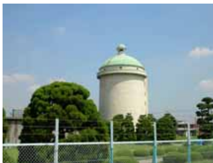
千葉県水道局栗山配水塔（松戸市）
