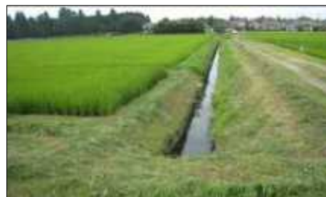
排水路による地下水調整
