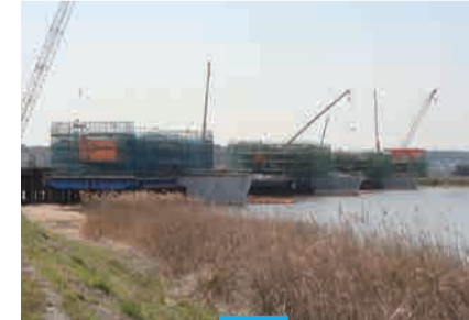
工事現場④高架・橋梁部(一体下部工) 印西市吉高千坂~成田市北須賀付近(仮称・印旛沼渡河橋)
