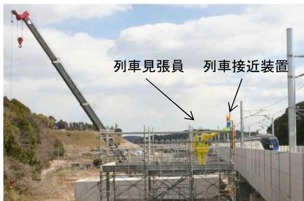
北千葉道路の作業が、成田新高速鉄道の防音壁から5m、軌道の端から60° の範囲内(ピンク斜線部)となる場合、列車通過時に作業を一時中止するなどの対策がとられています。
