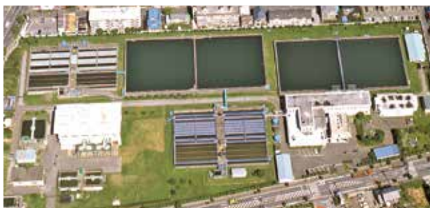
南八幡浄水場
