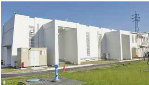
成田給水場 管理ポンプ棟
