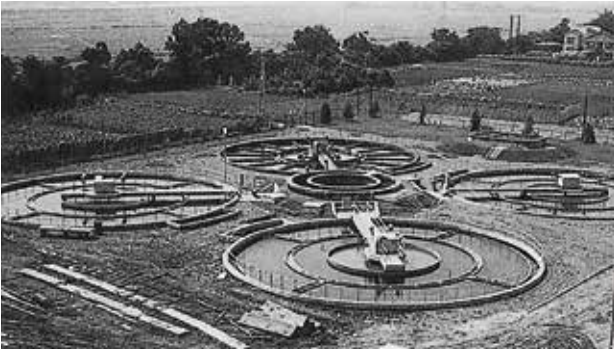
栗山浄水場沈でん池
