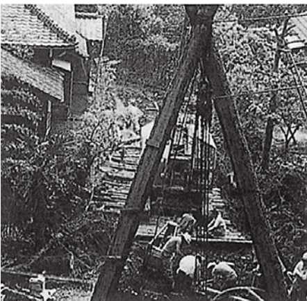
導水管布設工事（矢切取水場～栗山浄水場）
