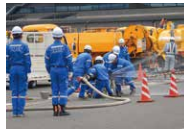
ライフライン復旧訓練の様子 (九都県市合同防災訓練)
