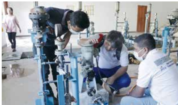
浄水場機器の調査の様子
