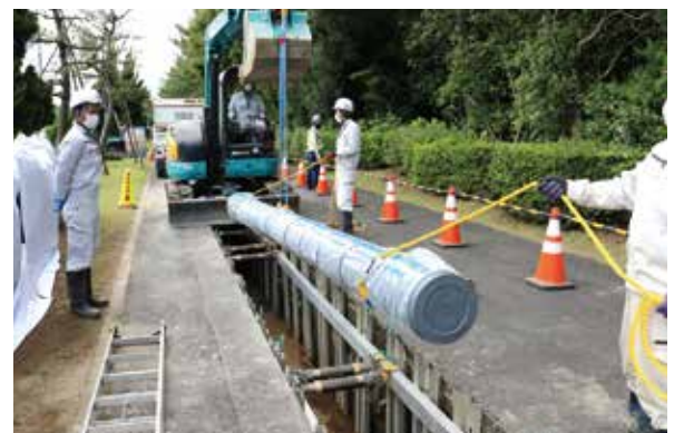
管路工事の様子
