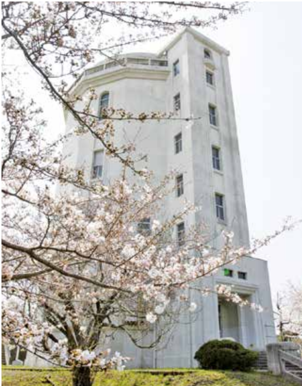
千葉浄水場（現千葉分場）の高架水槽
