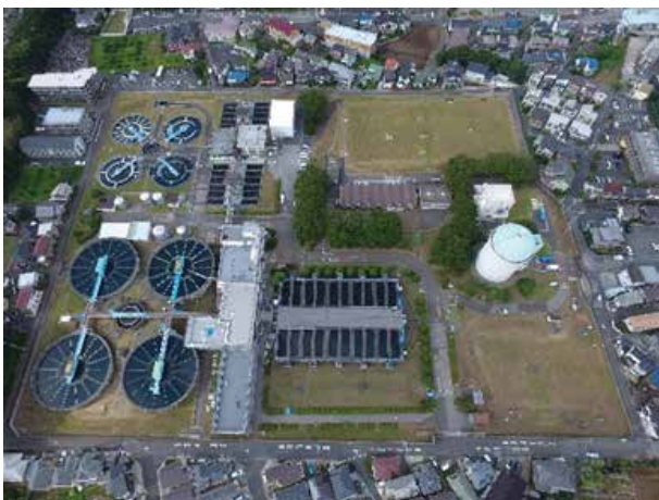
ちば野菊の里浄水場（第2期）施設整備事業
