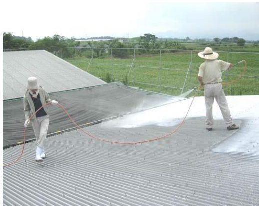
↑屋根への石灰の吹き付け
