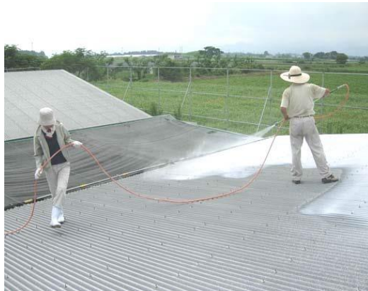
↑屋根への石灰の吹き付け
