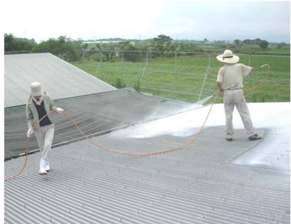
↑屋根への石灰の吹き付け
