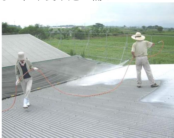
↑屋根への石灰の吹き付け
