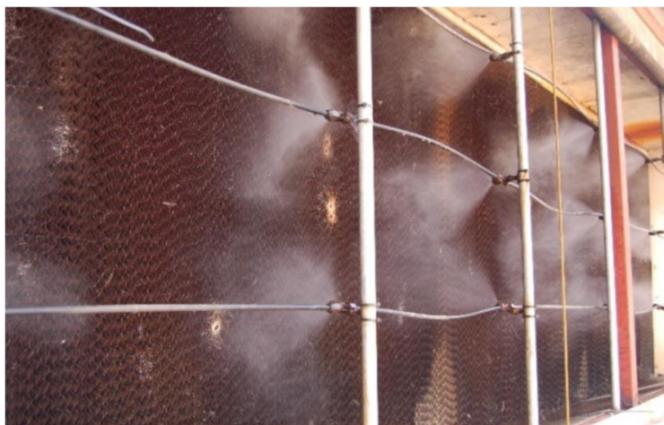
↑細霧装置による散水
