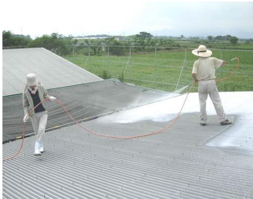
↑屋根への石灰の吹き付け
