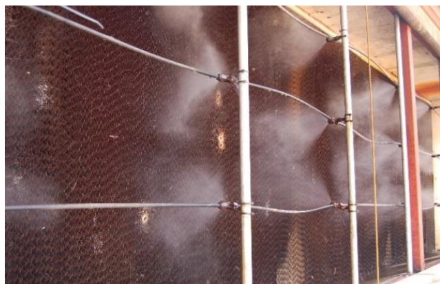
↑細霧装置による散水
