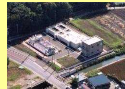
逆井河川浄化(リン除去)施設
