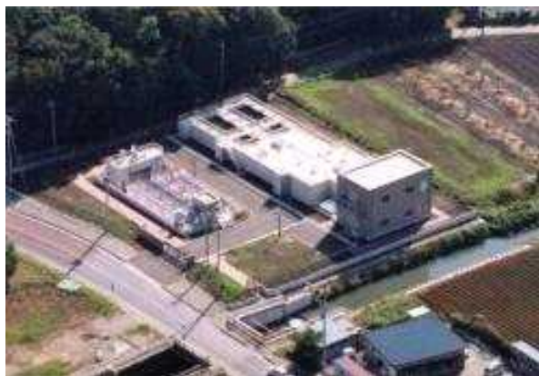
河川浄化施設(逆井河川浄化(リン除去)施設)
