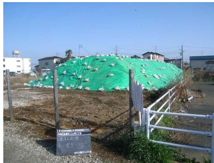
掘削土砂の有効活用
