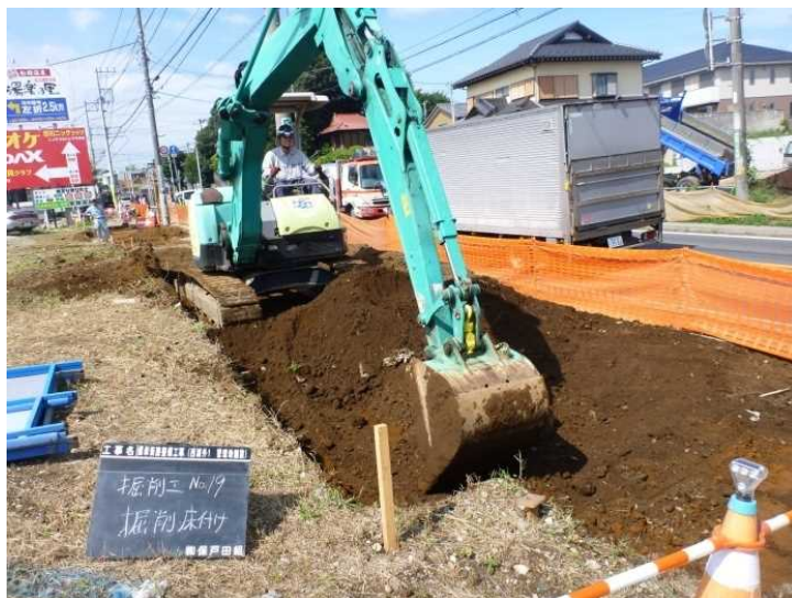
建設発生土の有効活用
