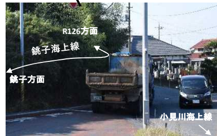
見通し・線形不良の県道交差点
