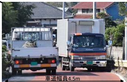
狭隘区間の状況
