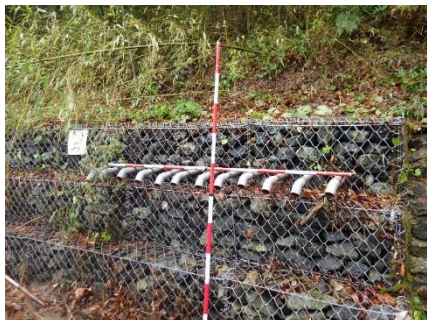
横ボーリング工
