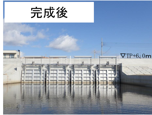
写真-5 開口部対策工事(矢挿川河口)
