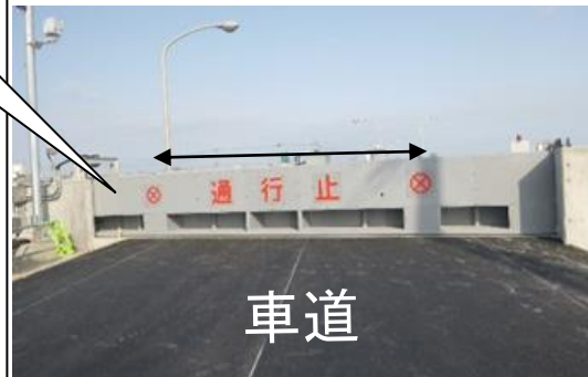
新一宮大橋 右岸 陸閘
